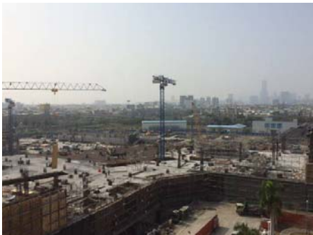
現在の工事の様子(3月5日)
