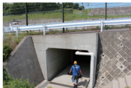
パドックからS字側へ直接アクセスできる「S字トンネル」の供用 が始まっています(レース・イベント時のみ。レースによっては パドック入場可能パスが必要です)。
